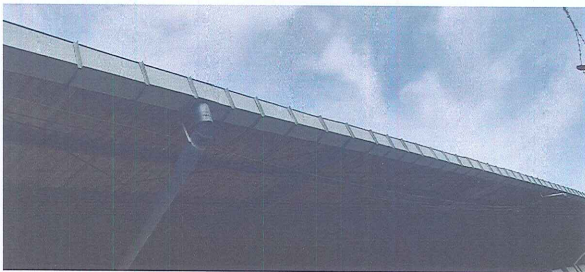
Canales de aguas lluvias
