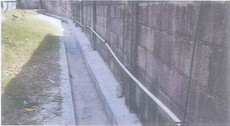
Construcción de canaleta de concreto
